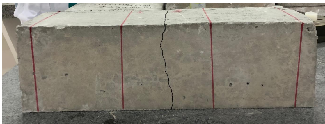
Figura 14: Viga trincada (Deformação elástica)
