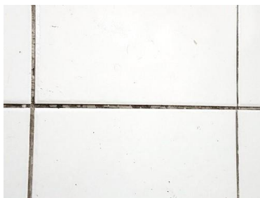
Figura 06 – Perda de rejunte na cerâmica da cozinha
