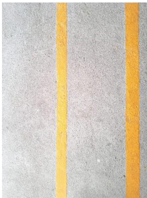
Figura 07 – Fissuras na garagem predial
