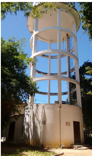
Figura 12 – Vista do reservatório superior
