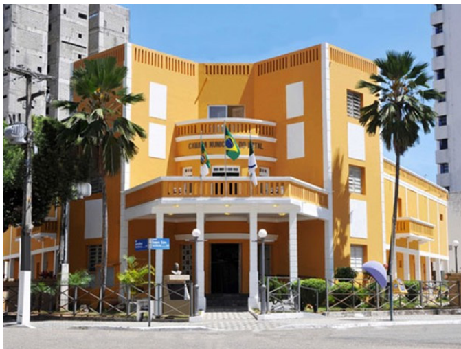
Figura 5- A imagem mostra como se encontra o prédio da Escola de Serviço Social. No atual momento, o prédio está sendo utilizado como a Câmara Municipal de Natal.
