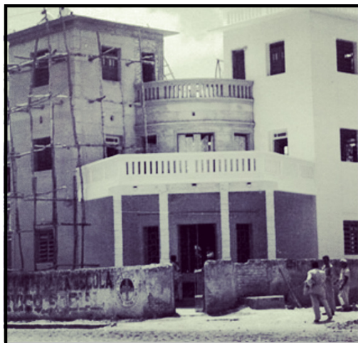
Figura 1- A imagem retrata os primeiros momentos da construção da Escola de Serviço Social e seu terreno recém-comprado localizado na Rua Jundiá
