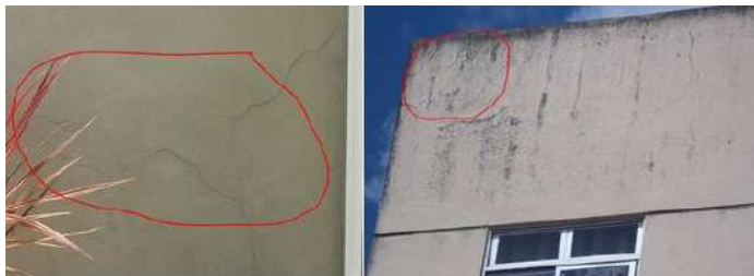
Figura 7 - Fissuras Mapeadas
