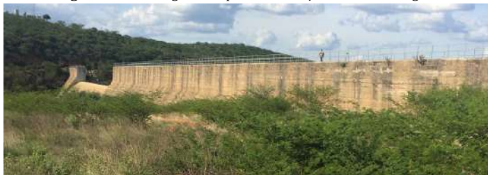
Figura 01 – Vista geral do paramento a jusante da barragem
