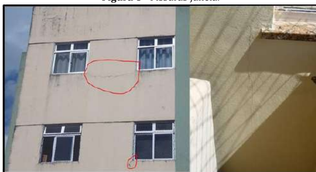
Figura 6 - Fissuras Janela.
