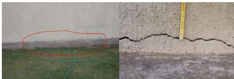
Figura 10 - Trincas Fachada
