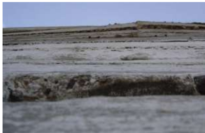
Figura 04 – Detalhe no sentido vertical do paramento a montante
