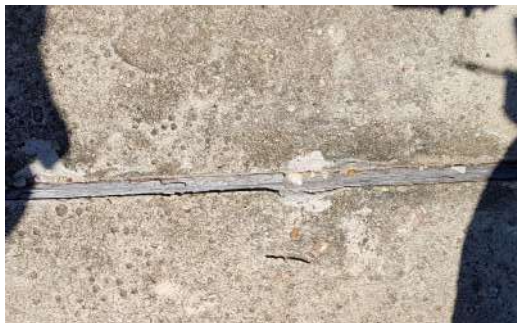
Figura 16 – Junta de dilatação utilizando madeira
