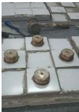
Figura 13 - Preparação dos corpos de prova da argamassa colante industrial piso sobre piso para o ensaio do Pull-Off
