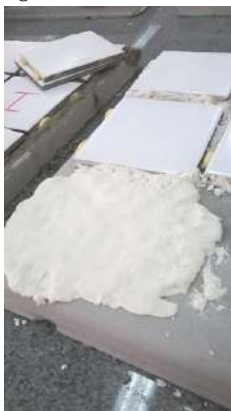
Figura 11 - Assentamento argamassa colante industrial ACII-E do fabricante "B"
