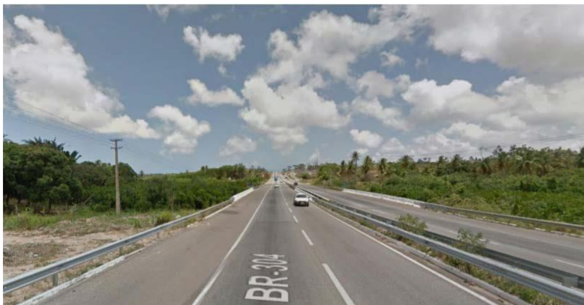
Figura 3 – Trecho da Pista Dupla
