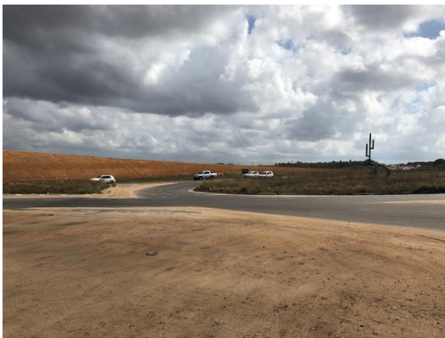
Figura 9 - Vista parcial de desmatamento para as obras da duplicação
