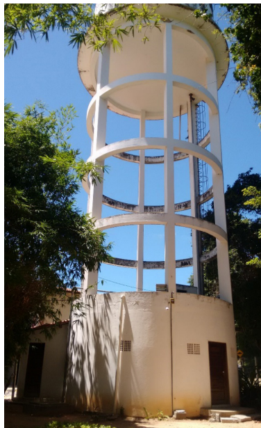
Figura 22 – Vista do reservatório Superior
