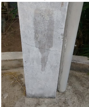
Figura 2 – Incolor – apresenta carbonatação
