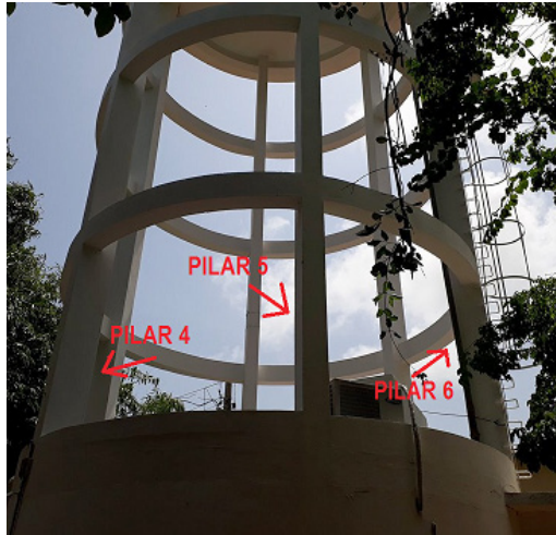
Figura 24 – Pilares do reservatório Superior
