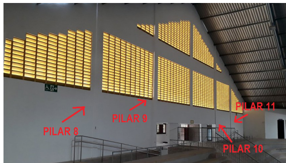
Figura 16 – Pilares do ginásio de integração
