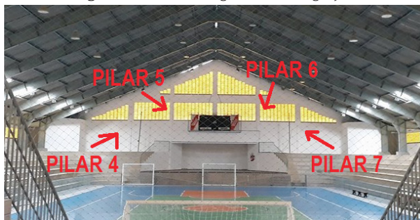
Figura 15 – Pilares do ginásio de integração
