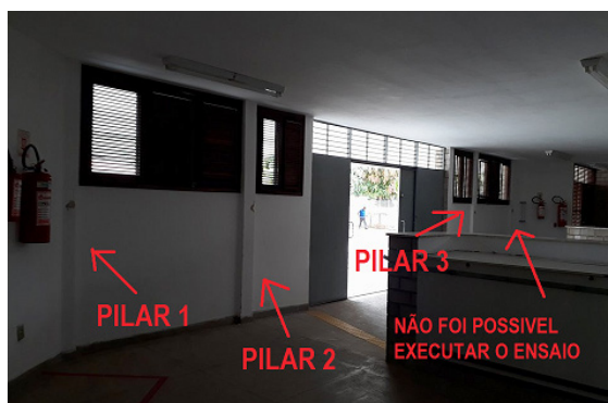
Figura 14 – Pilares do ginásio de integração
