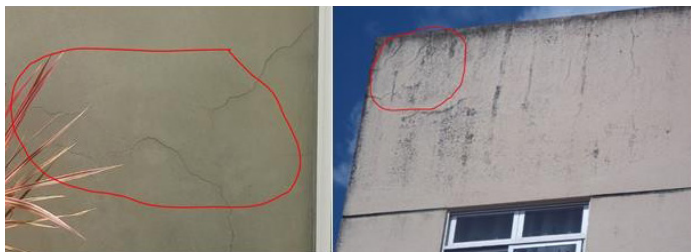
Figura 7 - Fissuras Mapeadas
