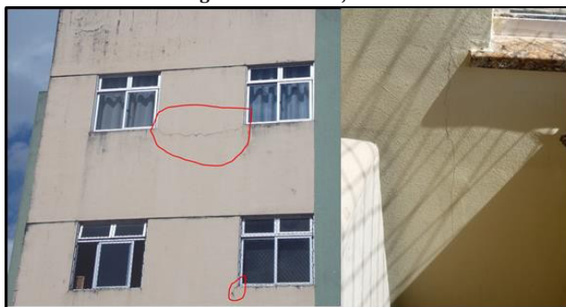
Figura 6 - Fissuras Janela.
