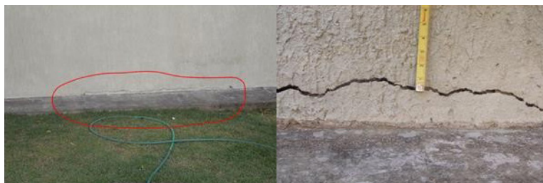
Figura 10 - Trincas Fachada
