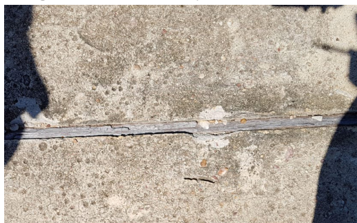
Figura 16 – Junta de dilatação utilizando madeira
