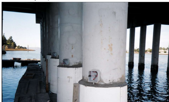
Figura 9 – Recuperação de Colunas da Ponte San Leandro, Califórnia
