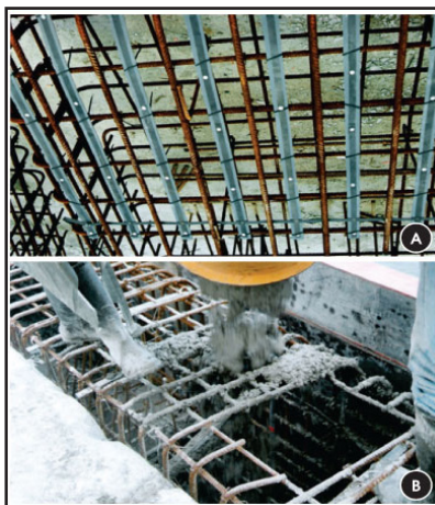
Figura 12 – Instalação das fitas (A) e concretagem (B)
