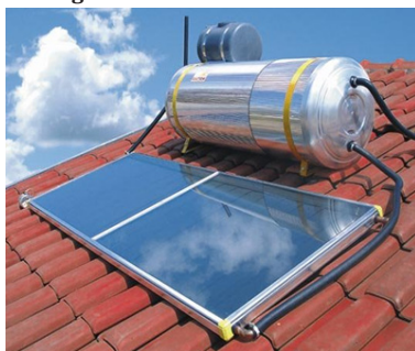
Figura 5 – Coletor solar fechado
