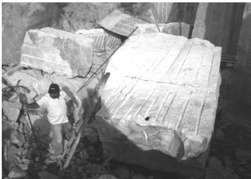
Fotografia 1: Esquadrejamento com explosivos, sendo utilizado cordel detonante
