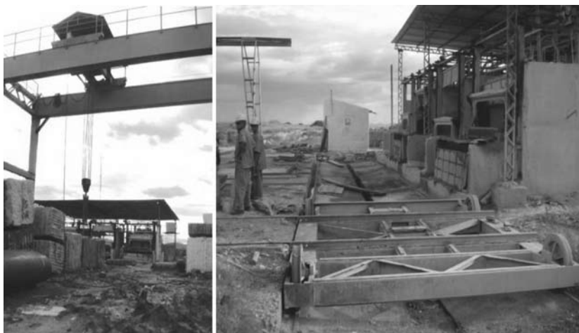
Fotografia 3: (a) Pátio de Blocos com pórtico; (b) Carros de transferência
